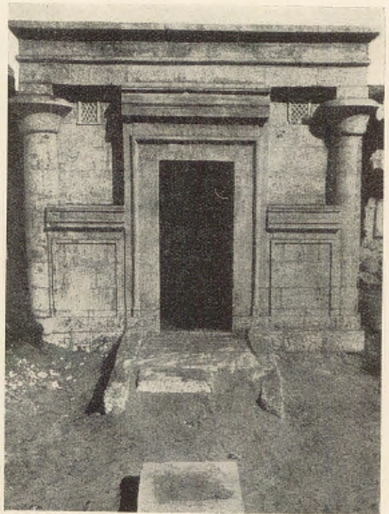
b) Temple d'époque ptolémaïque avec deux rampes encadrant l'escalier.
